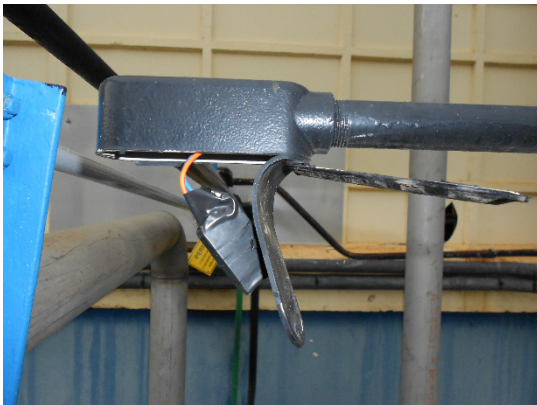
Fig 3- Terminador de segmento "instalado" dentro do eletrodutos
